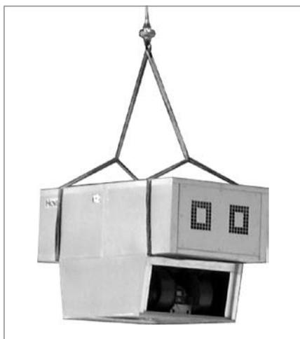
Fig. C5: Les appareils RoofVent® sont installés depuis la toiture.
