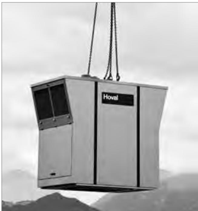
Image F6 : Levage de l'appareil de toiture au moyen des mousquetons vissés
